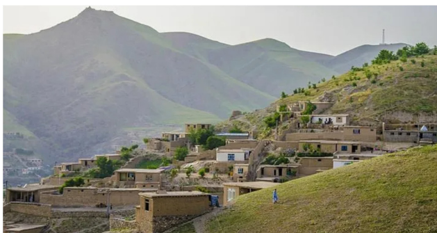
Рис.2. Восточный Кишлак в долине гор. Проектирование кишлака в качестве образца для архитектурного дизайна отелей. [9].
