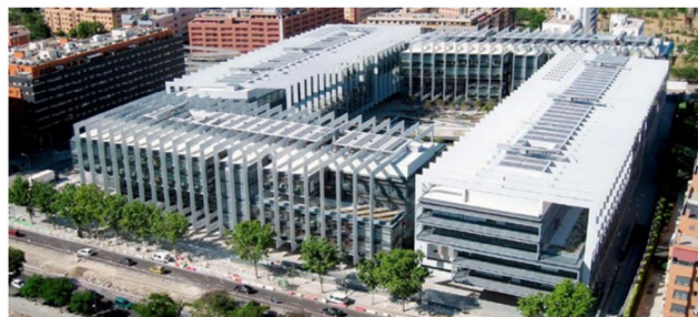
Рис. 4 - Кампус Repsol в Испании. Вид с высоты птичьего полета (Чистякова, 2023, 172)
