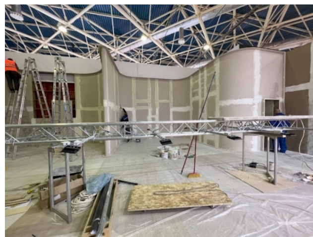
Рис 4. Фото в процессе работы.
